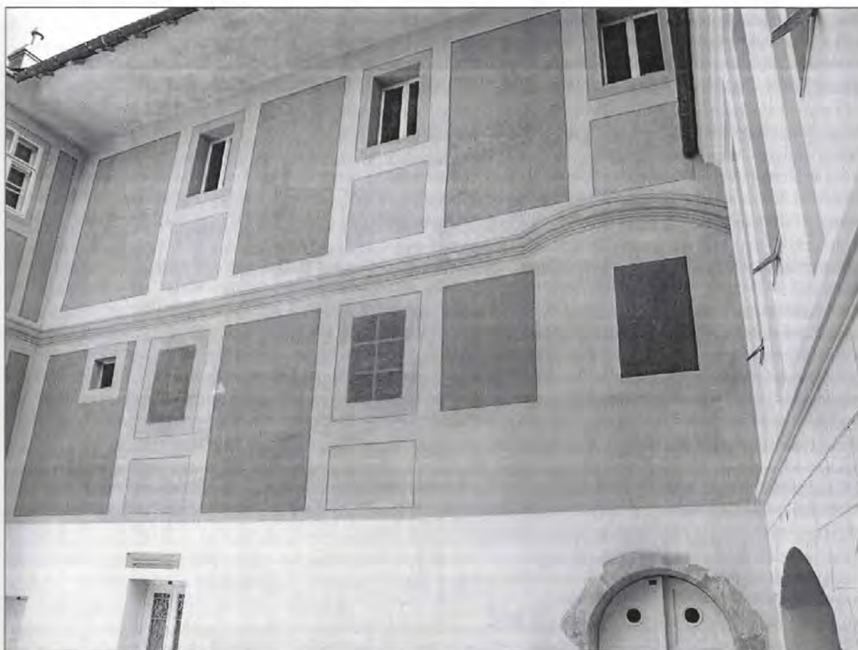
Část rekonstruovaného průčelí paláce na horním nádvoří (foto T. Vitek, 2004)
