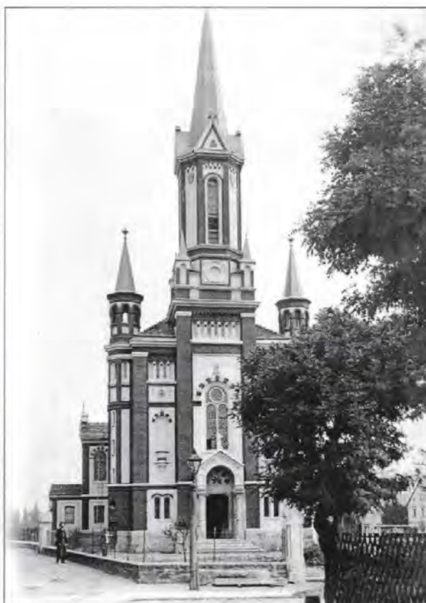
Dokončené průčelí kostela, 1898 (SOKA Jeseník)
