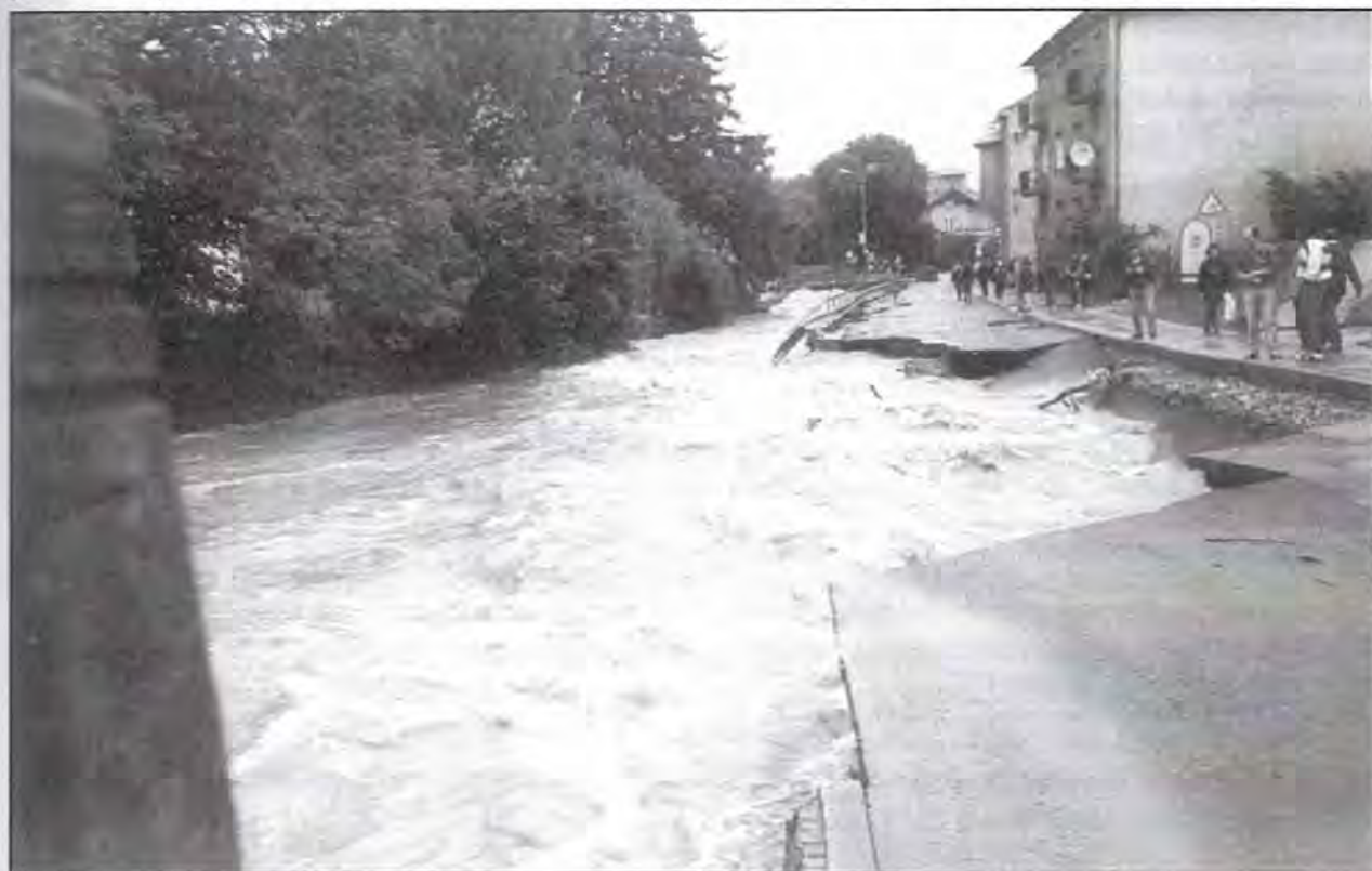
Následky povodně na Fučíkově ulici, 1997 (SOKA Jeseník)
