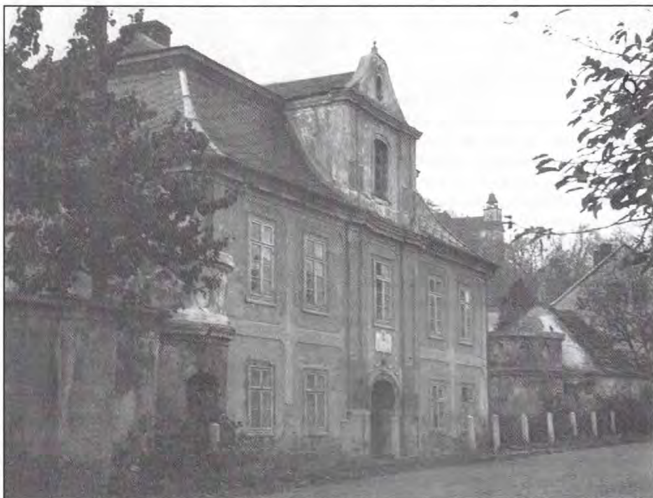
Javorník s Dittersovým domem, stav v 50. letech (SOKA Jeseník)
