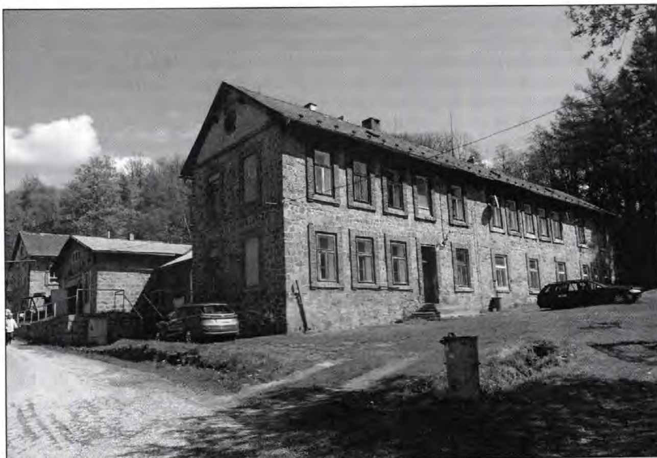
obr. 4 Objekty tzv. staré školy, současný stav
