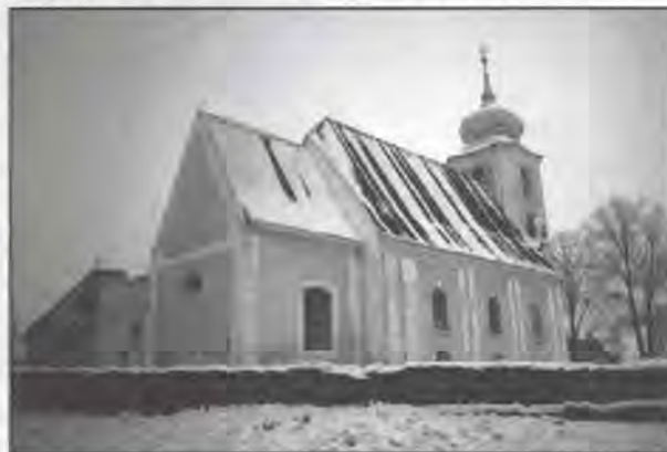
Stará Červená Voda, kostel Božího těla, celek od severovýchodu, asi 1255-1265 a mladší úpravy (foto: Dalibor Prix, 1998)
