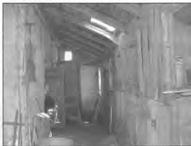
Chodba pod námětkem střechy
