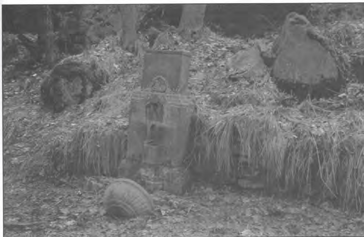
Mecklenburský pramen, stav před opravou
