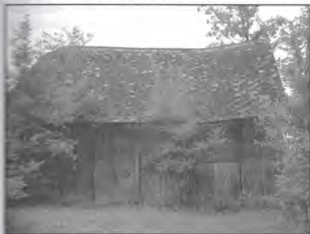
Stodola bedněná trojdílná
