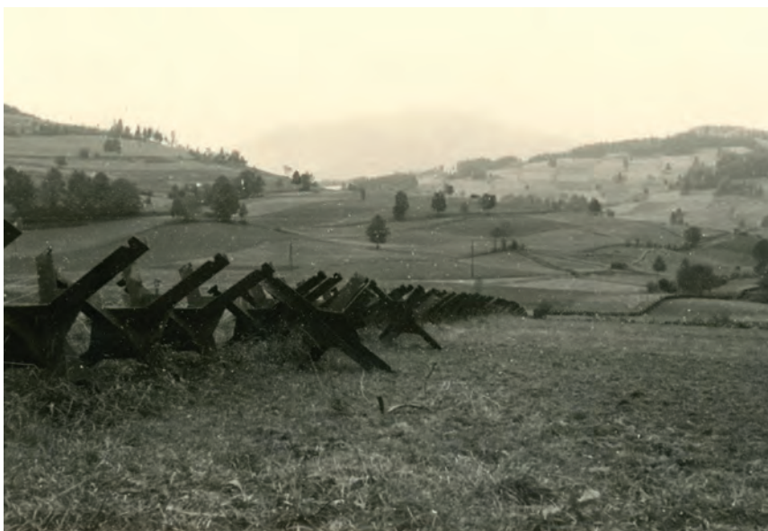
Obr. 3 Ukázka jednořadé překážky z ocelových rozsocháčů s dřevěnou protipěchotní překážkou u objektu v Domašově XIV-20-A-160 ve směru k Šeráku (zdroj: archiv Petra Mackovčina)
