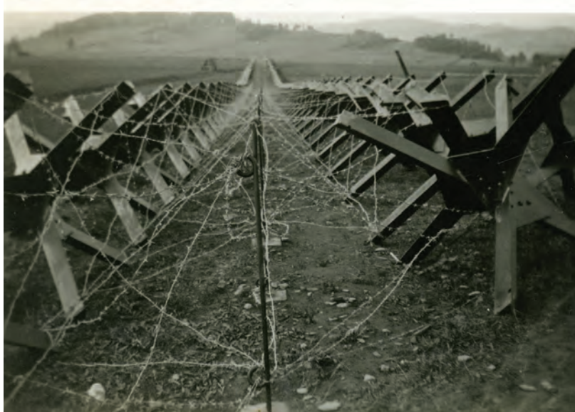
Obr. 4 Ukázka dvouřadé překážky z ocelových rozsocháčů s použitím tříokých kolíků se zapleteným ostnatým drátem u objektu XIV-76-A-160 v údolí Šumného potoka (zdroj: archiv Petra Mackovčina)
