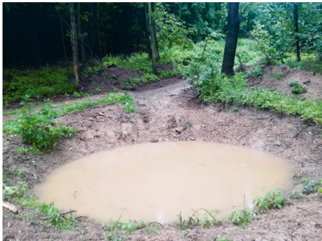
Zemní průleh na svážnici ukončený vsakovací jámkou (revír Hoštice, foto autor).
