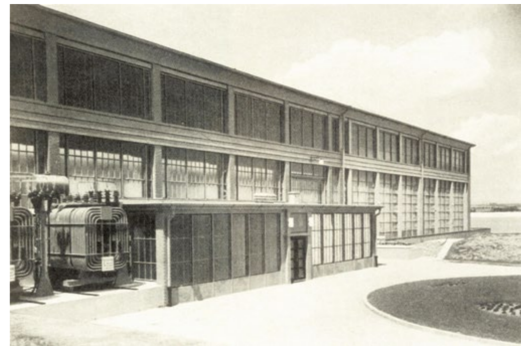
Hala elektrowni wybudowana na koronie zapory. (VOLLMER P.: Die staubeckenanlage Otmmachau, s. 41).
