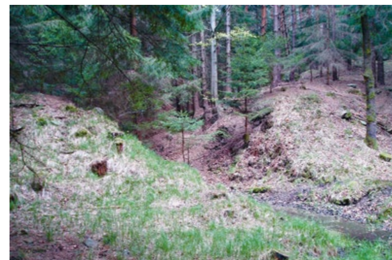
Obr. 5 Hráz nádrže „Grenzteich“ v místě bývalého vypouštěcího zařízení (foto autor).
