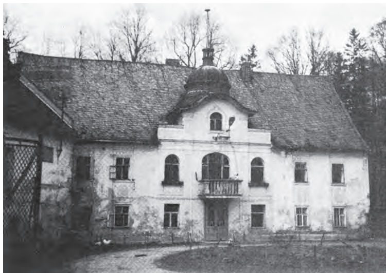
Obr. 3 Dvorní zámecké průčelí od jihu, stav před rokem 1983 (Pachl 1983, s. 419)
