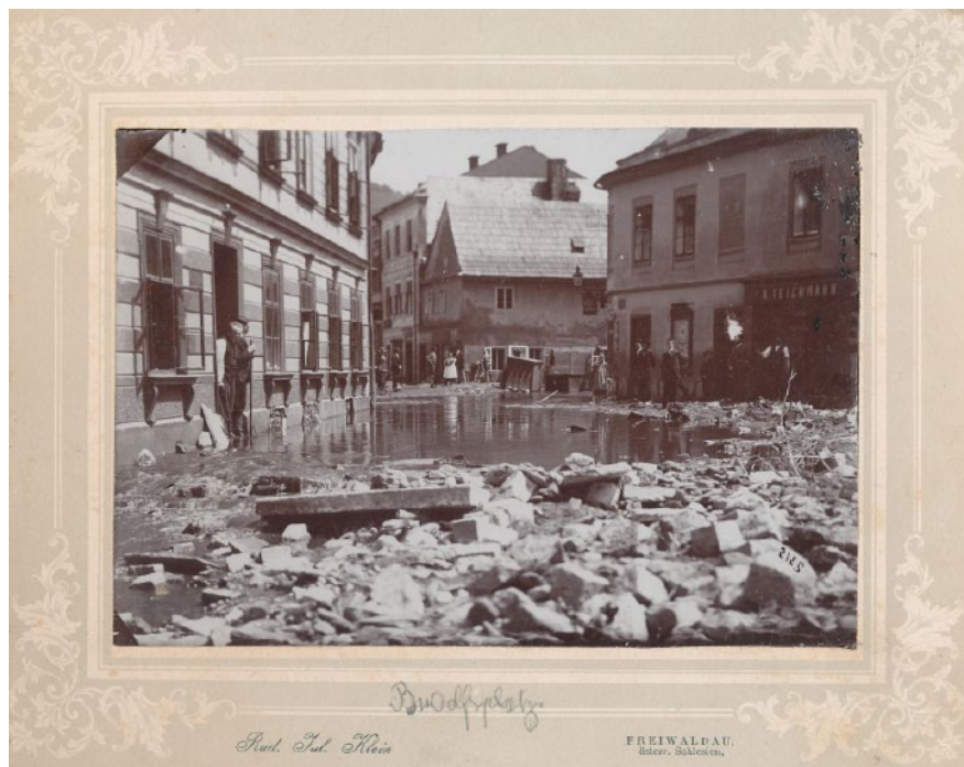
Rudolf J. Klein, následky povodně v Jeseníku u Schrothova domu, 1903 (soukromá sbírka)
